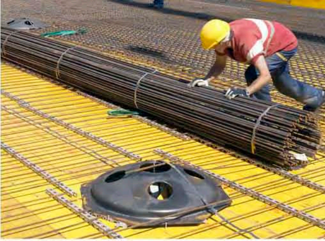
Bamtec-mattoraidoitea levitetään työmaalla.
