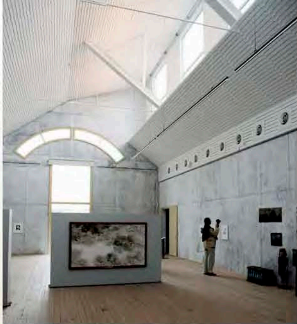
Vakiopalkkimuotilla toteutettua seinäpintaa: Läänimuseo, Jönköping, Carl Nyrén 1991.
