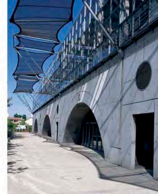
Vakiopalkkimuotilla toteutettua seinäpintaa: Arkkitehtikoulu, Lyon, Jourda & Perraud 1987.
